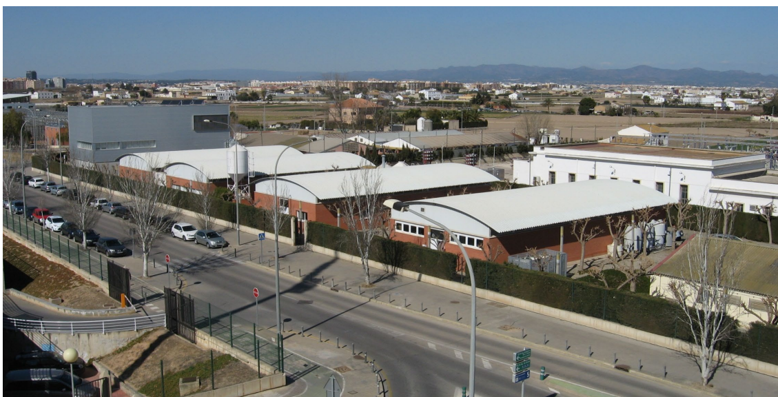
Vista de las naves, plantas piloto y edificio multiusos del ICTA
